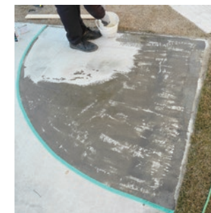
2.下地にプライマー塗布
