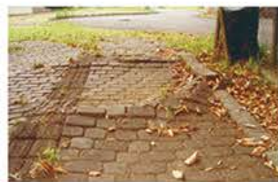
舗装部の持ち上がり防止に
