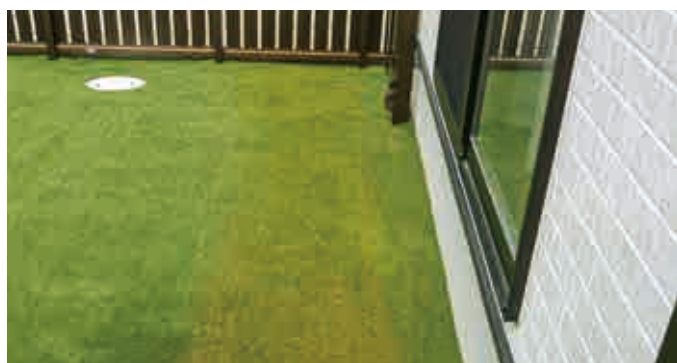
太陽光の反射熱で人工芝が縮んだ例
