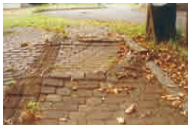
舗装部の持ち上がり防止に
