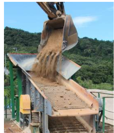
重機を使う現場は大迫力
